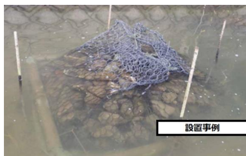
図2. 石倉カゴ設置事例
