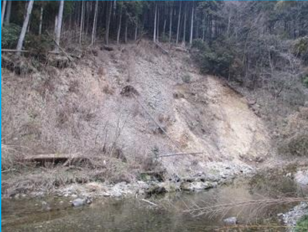
上流の崩落部分
